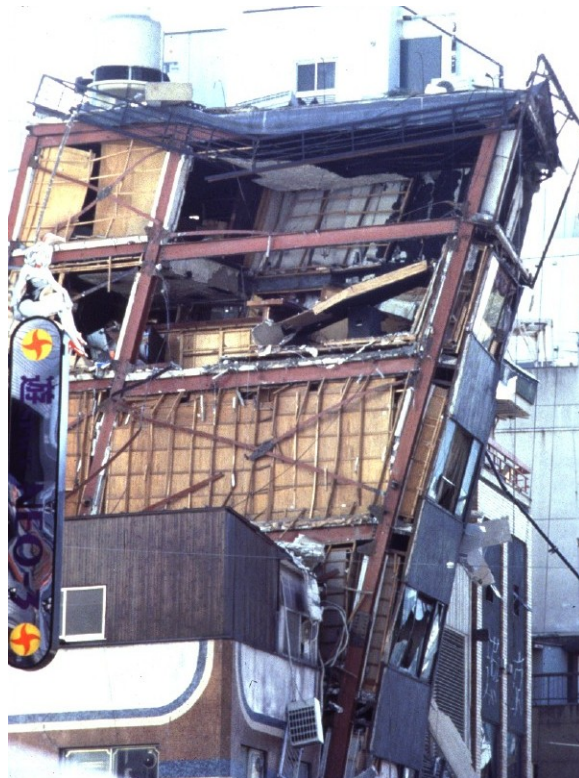
Σχ. 4 Kobe, 1995. Αστοχία φορέα λόγω αυξημένων μετακινήσεων, αστοχία συνδέσμων ακαμψίας
