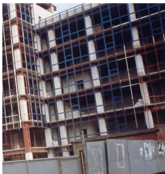
Σχ. 7 Σαφήνεια δομικού συστήματος συνεχής ροή των φορτίων προς το έδαφος, μόρφωση συστήματος εξασφαλίζοντας δυσκαμψία, ευστάθεια, αντοχή και πλαστιμότητα
