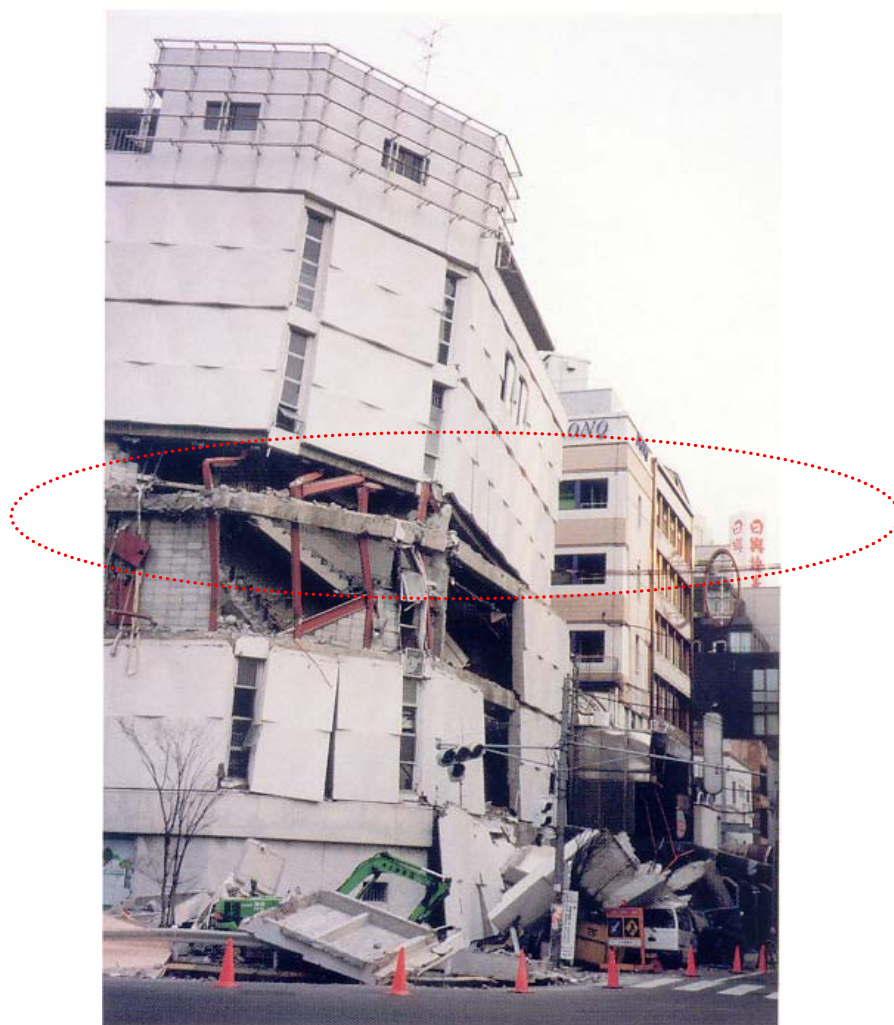
Σχ. 3 Kobe, 1995. Σχηματισμός μηχανισμού ορόφου
