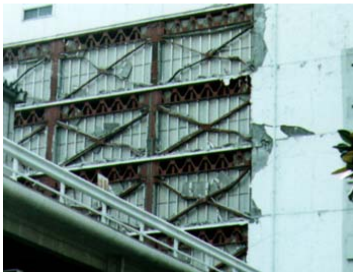
Σχ. 4 Kobe, 1995. Αστοχία φορέα λόγω αυξημένων μετακινήσεων, αστοχία συνδέσμων ακαμψίας
